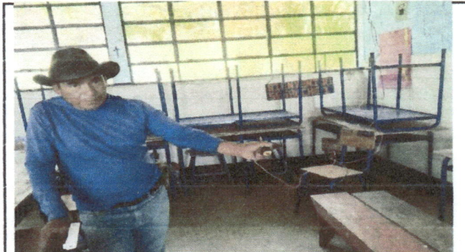
Foto 4: ES DE URGENCIA LA INSTALACION DEL CABLEADO ELECTRICO, YA SE PRETENDE COMPRAR UN PANEL SOLAR, YA EL CNB REQUIERE EL USO DE LA TECNOLOGIA.
